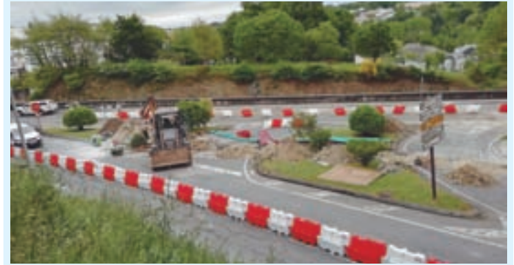
Unha vista das obras da nova rotonda
