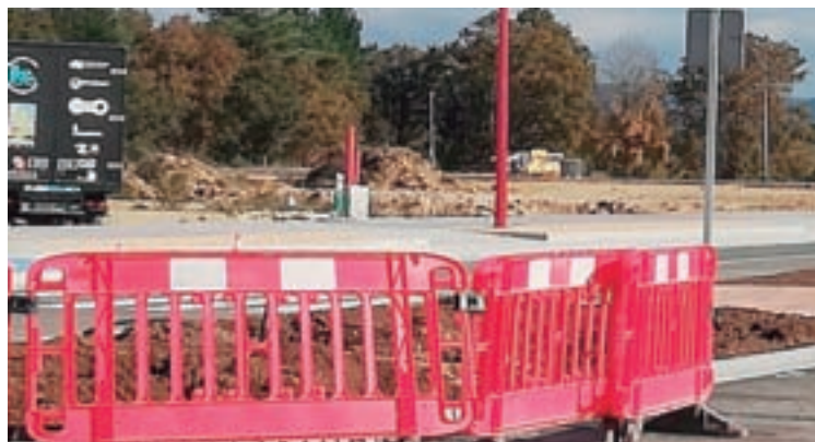
Unha imaxe das obras das Gándaras
