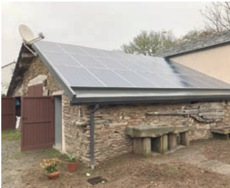
Instalación de paneis solares nunha vivenda
