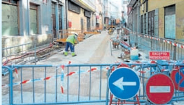
Imaxe de arquivo das obras en Recatelo
